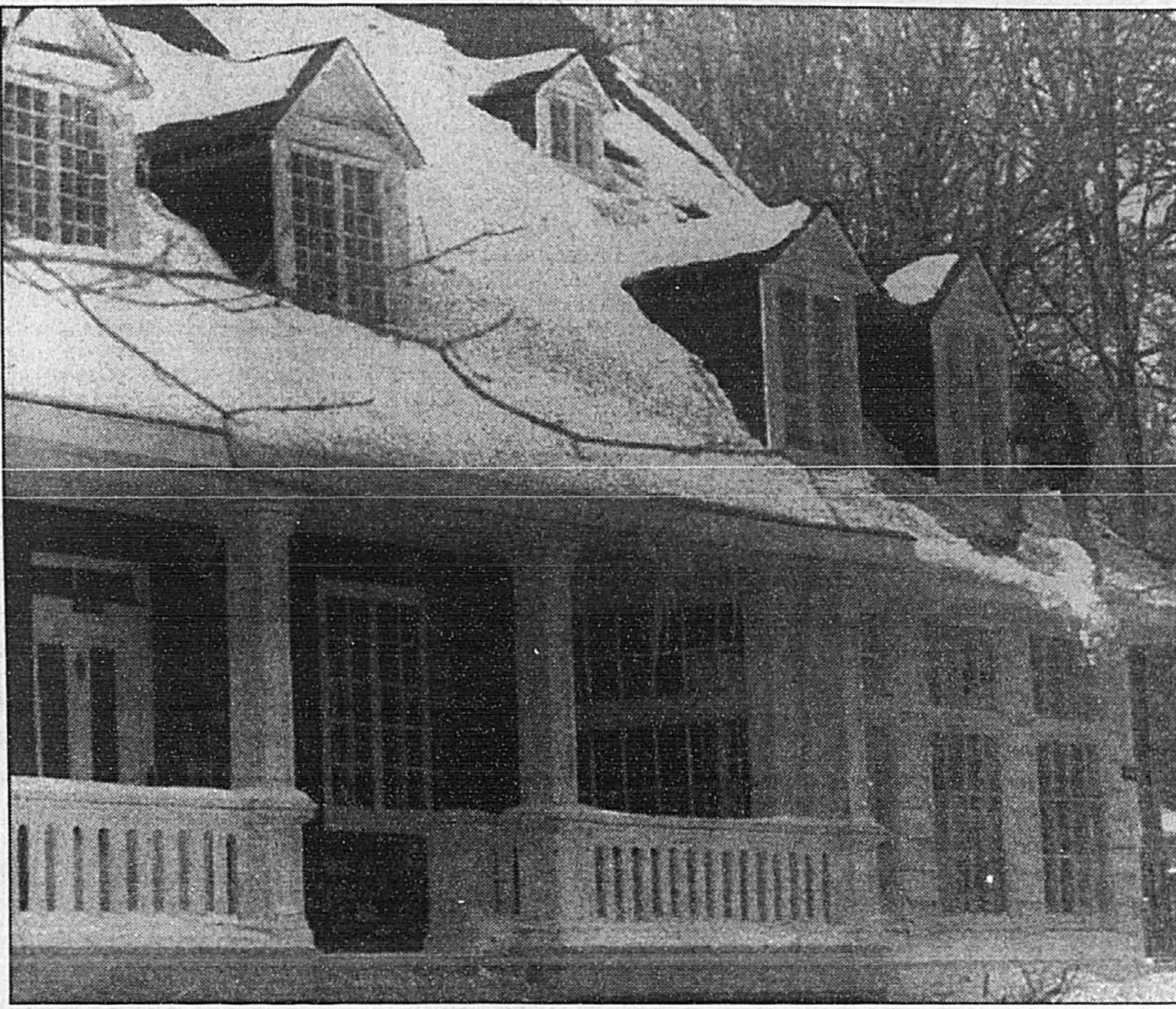
La maison Hurtubise, située au 563, chemin de la Côte-Saint-Antoine, à Westmount, est l'un des plus vieux bâtiments de l'île de Montréal. Sa construction remonte à 1688. Elle est aujourd'hui la propriété de Héritage canadien du Québec.
