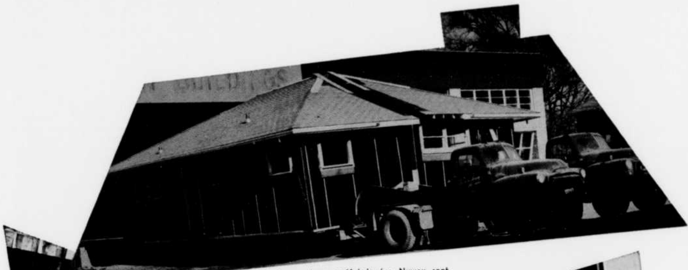
Les maisons préfabriquées Nuway sont livrées en deux entités égales, complètes, qu'il suffit de réunir, sur le site même de la maison à ériger.
