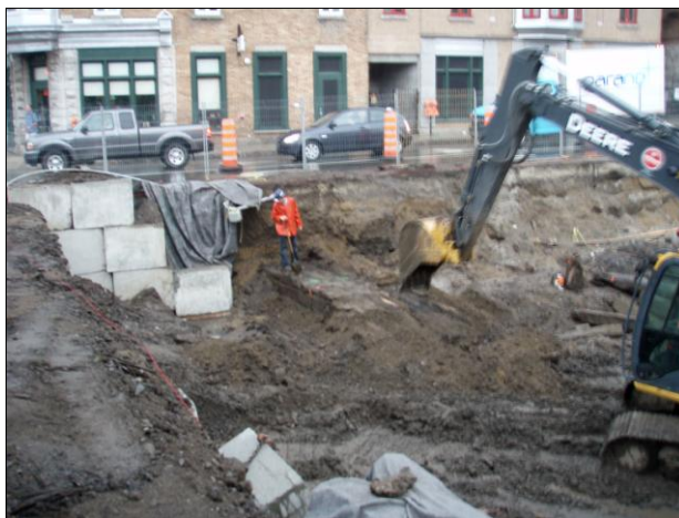
Photo 1 Angle des rues Saint-Paul et des Vaisseaux-du-Roi, travaux d'étaisonnement
