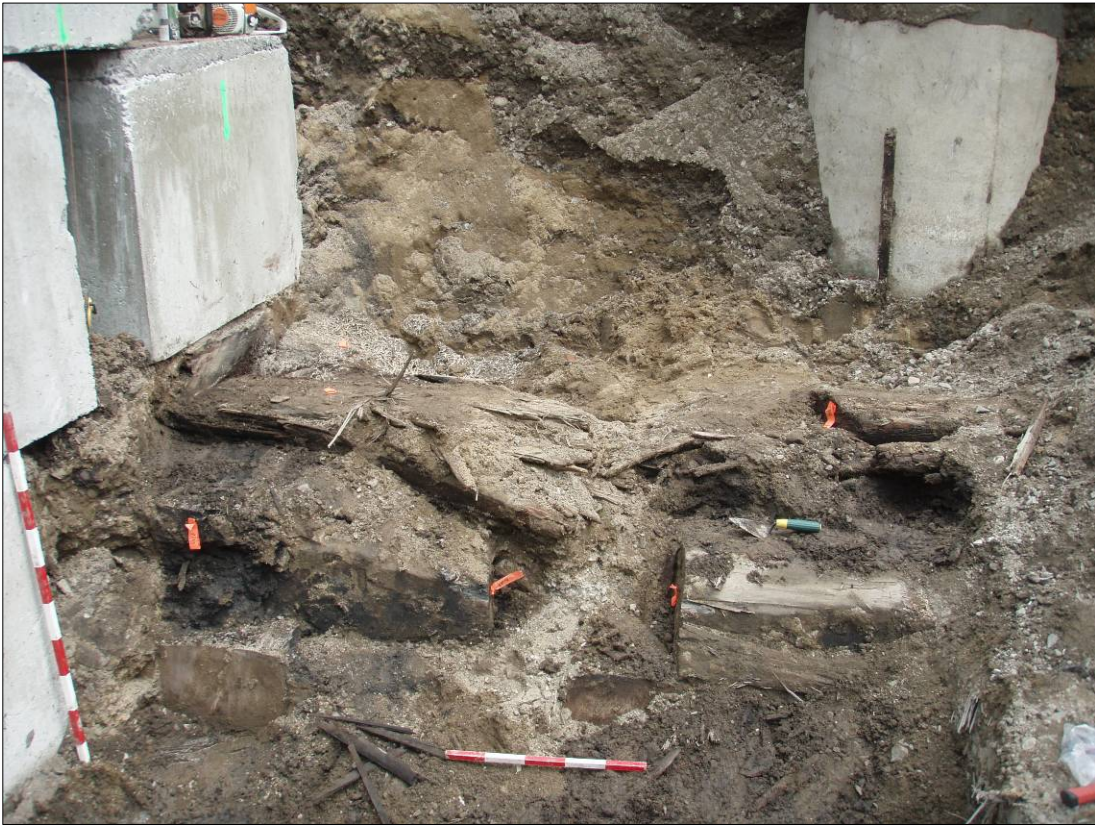
Photo 2 Cale de construction, P39 à P45 en place, vue vers l'est
