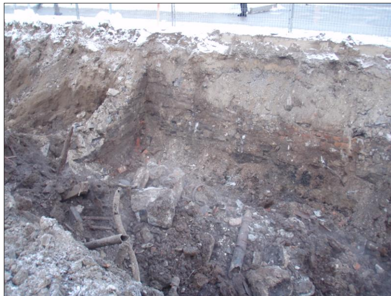
Photo 3 Coin formé par les murs 16B5 et 16B10, vue vers le nord-ouest
