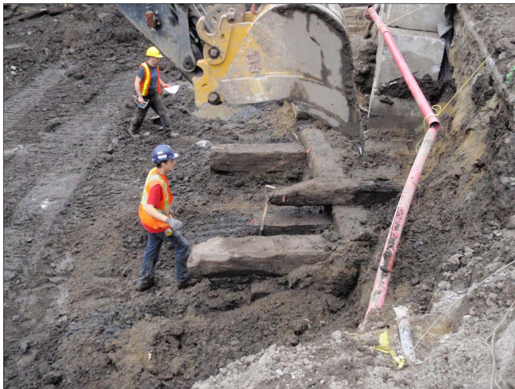
Photo 4 Sous-opérations 16C et 16D, vue générale de l'installation du mur de blocs de béton
