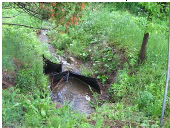
Photo 2: Barrières à sédiments dans un fossé nouvellement entretenu.
