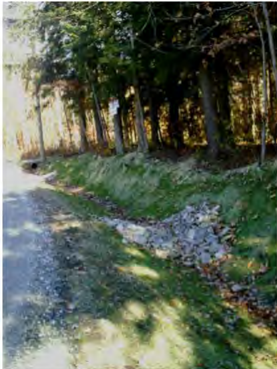
Photo 3: Stabilisation d'un nouveau fossé par ensemencement hydrolique et seuil d'écoulement, Canton d'Orford.
