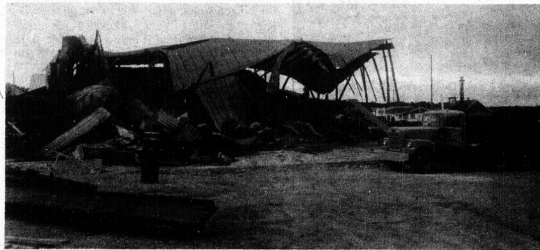
En cours depuis le 7 juillet, la démolition de la Coop incendiée reste à compléter.
