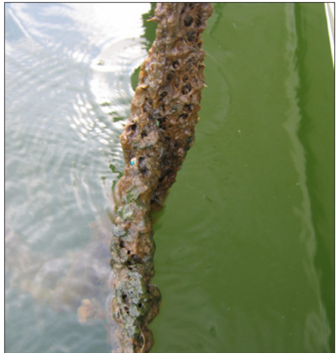
Photo 8. Collecteur recouvert par les algues lors du saumurage le 4 juillet 2006
