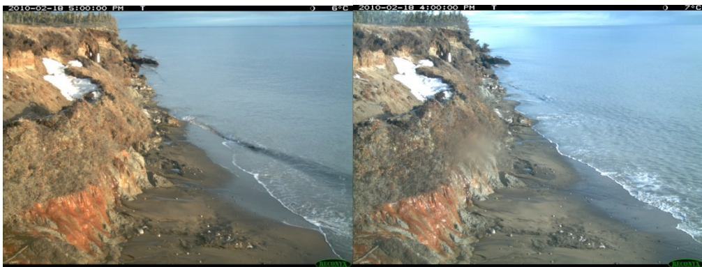
Figure 111 État de la nappe d'eau : sans énergie
