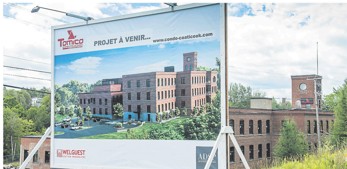
L'ancienne usine Belding-Corticelli, un élément indissociable du paysage de Coaticook, aura enfin une nouvelle vocation, puisque 65 condos seront aménagés dans l'usine de textile construite en 1886. — PHOTO SPECTRE MÉDIA, JESSICA GARNEAU
