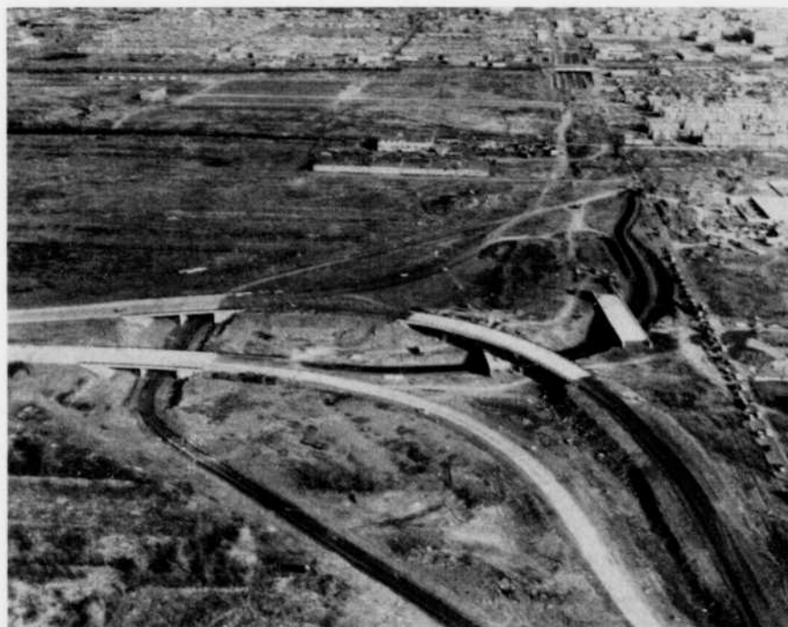
Raccordement au boulevard Métropolitain. Vue ouest-est.
