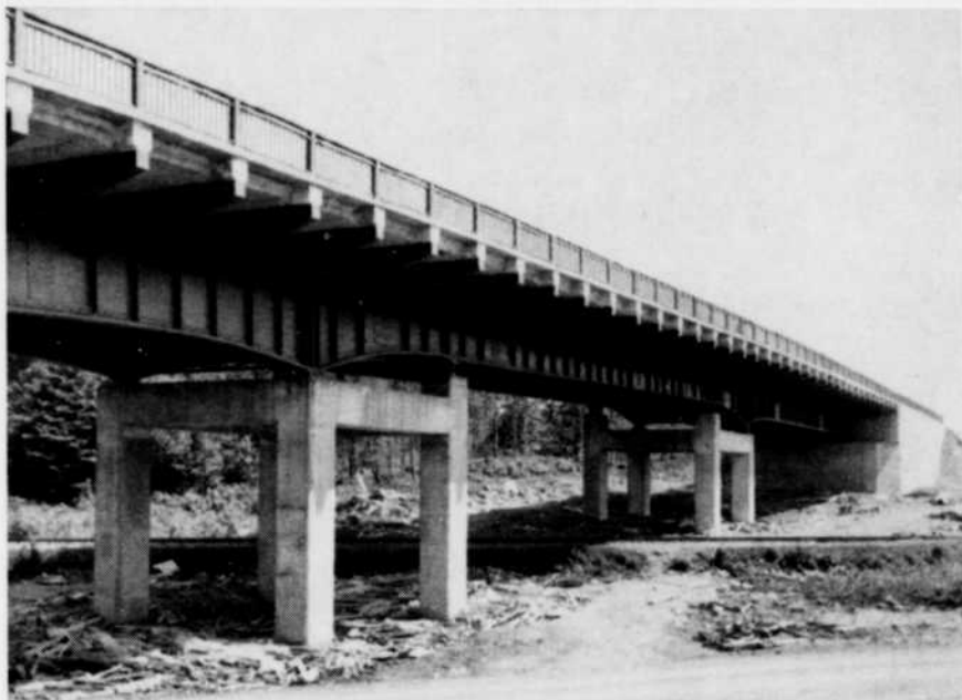
Structure du viaduc au-dessus des voies de C.N.R. sur l'Autoroute Montréal-Laurentides à St-Jérôme
