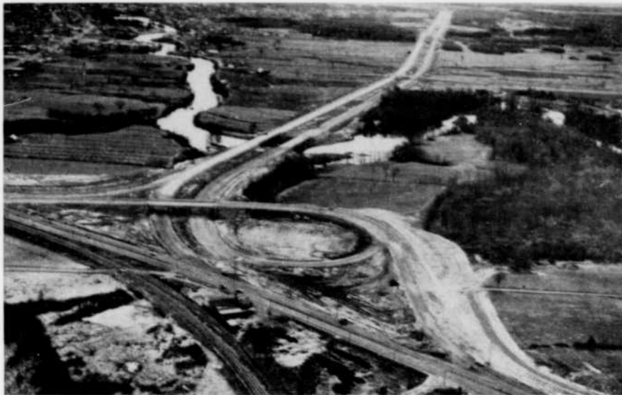
Raccordement à la route no 11 à St-Jérôme. Vue vers Montréal.
