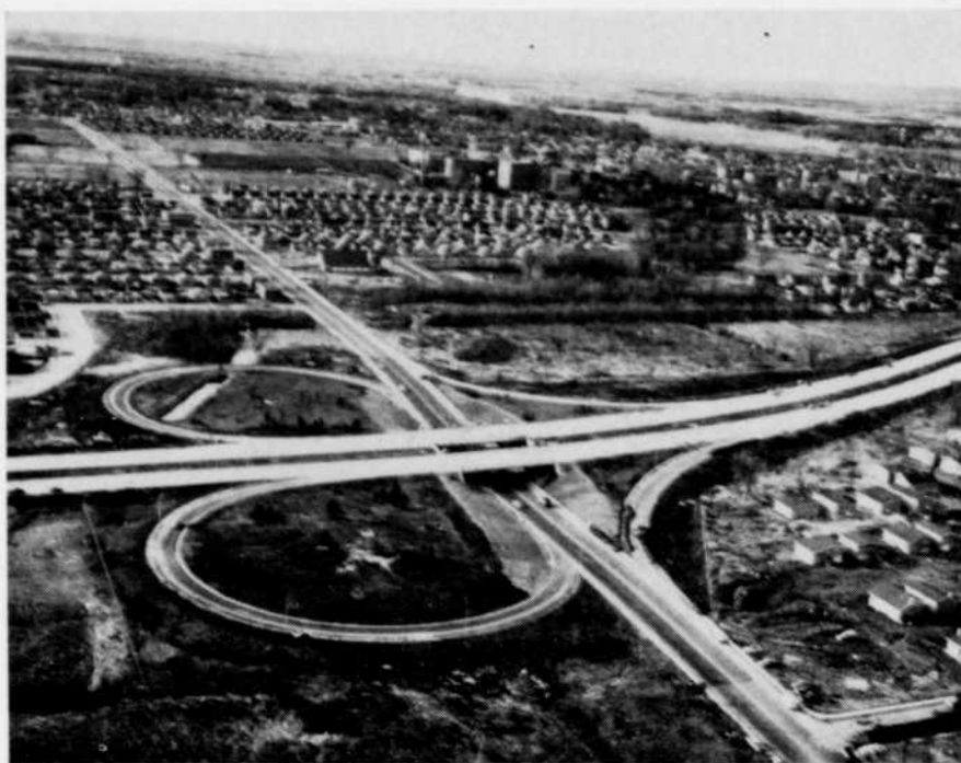
Intersection avec la rue de Salaberry. Vue est-ouest.
