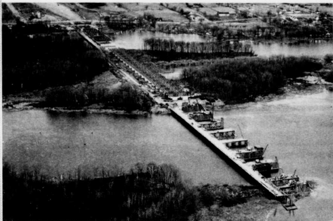
Le pont de la rivière des Mille-Îles sur l'Autoroute Montréal-Laurentides.
