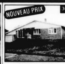
Secteur tranquille, revêtement refait, faites vite!
