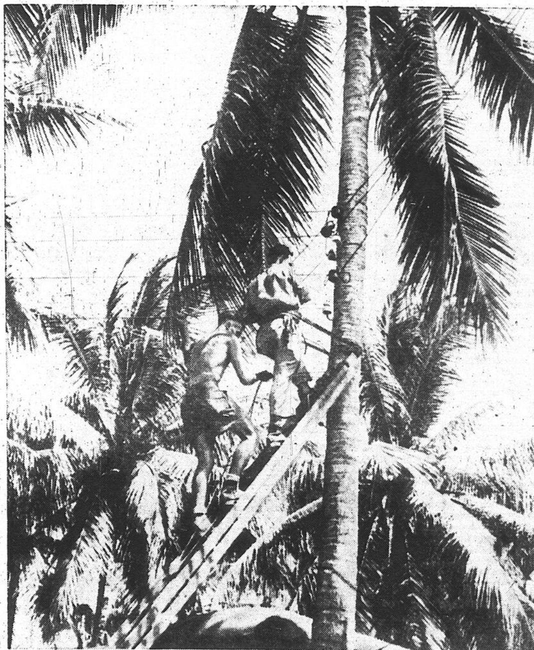
Un poteau de téléphone, type Nouvelle-Guinée. Bons Unies. Le palmier deviendra porte-fils à nouer des communications vers une base avancée des Natchez soldats américains sont à y établir des lignes velles.
