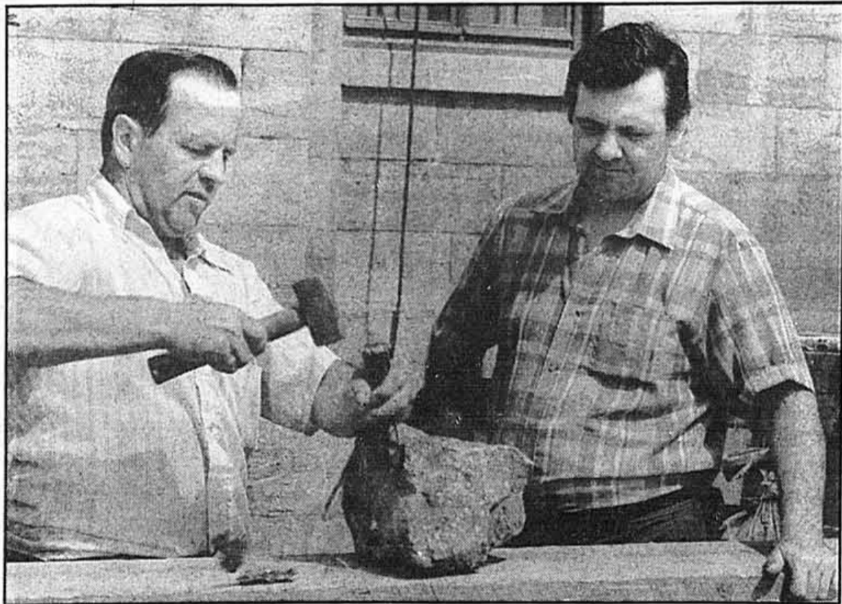
Roland Paradis, le patron, observe son contremaître Marcel Paradis qui prépare une pierre d'angle. En moyenne, la préparation d'une seule pierre demande une cinquantaine de coups de masse.
