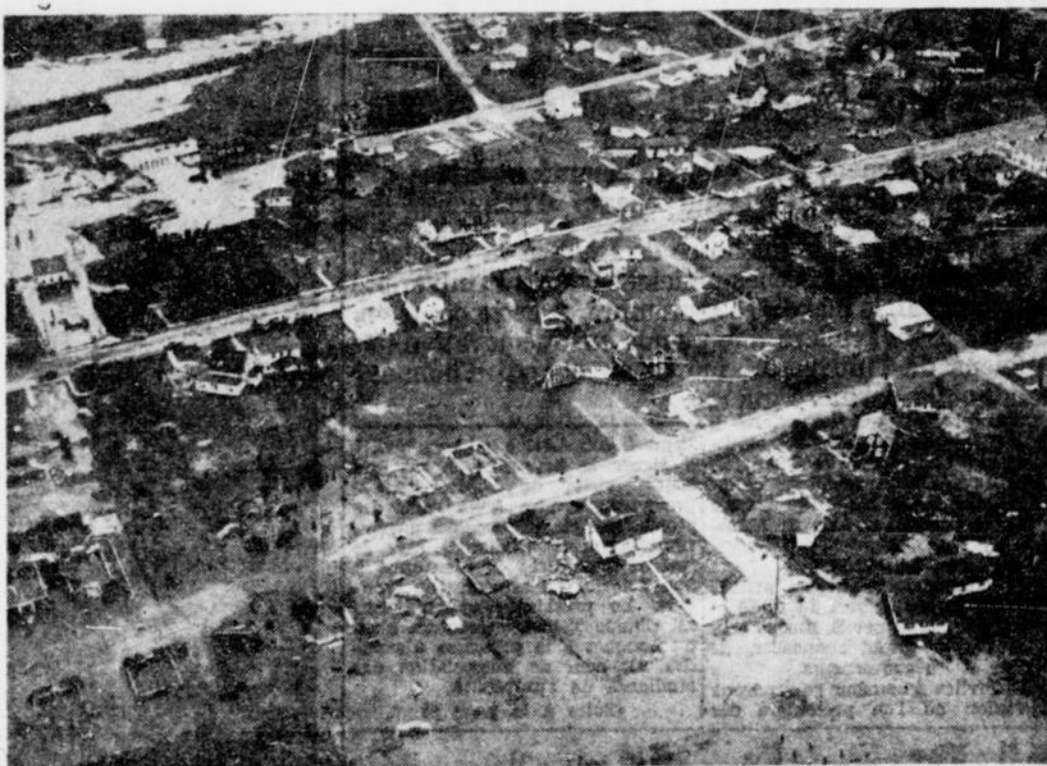
CI-HAUT, UNE VUE AERIENNE DES DOMMAGES CAUSES par l'ouragan Carol dans la région de New-London, Conn., aux Etats-Unis. Plusieurs maisons ont été arrachées de leurs fondations par des vents qui soufflaient à des vitesses allant jusqu'à 125 milles à l'heure.
