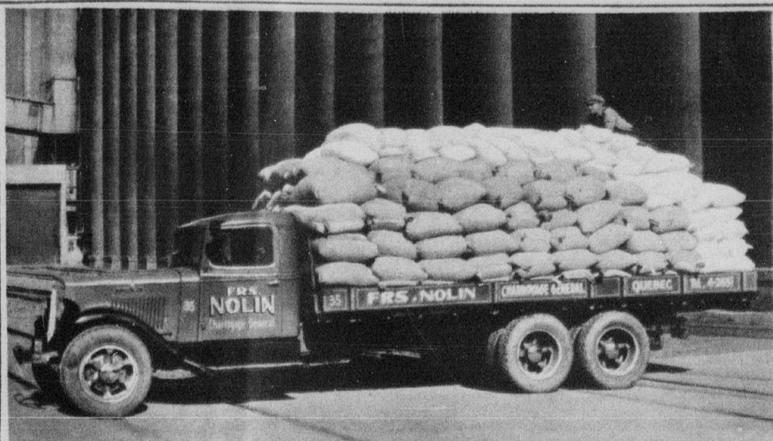
Ci-haut: Ce gros camion à six roues est un modèle International CS-40-T. Un essieu arrière à 2 vitesses est relié aux six roues (type essieu porteur d'arrière) pour conférer à ce camion une capacité et une puissance extraordinaires. Il appartient à Frs Nolin, charroyage général, Québec.
