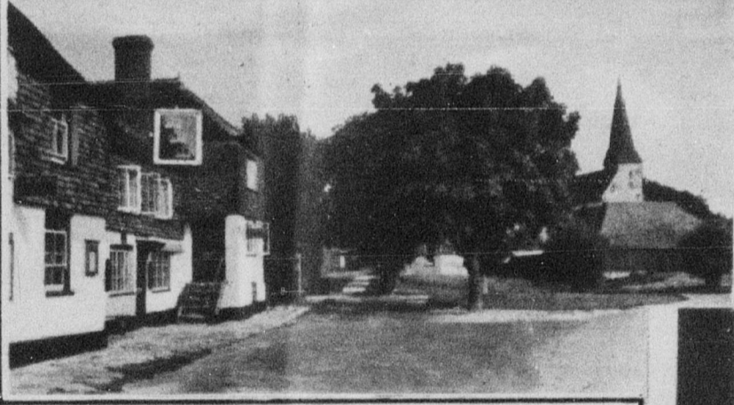
L'Auberge des Trois Couronnes et l'Eglise de Wisborough Green, Sussex.
