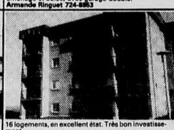
16 logements, en excellent état. Très bon investissement. Ginette T. Morin 724-6539
