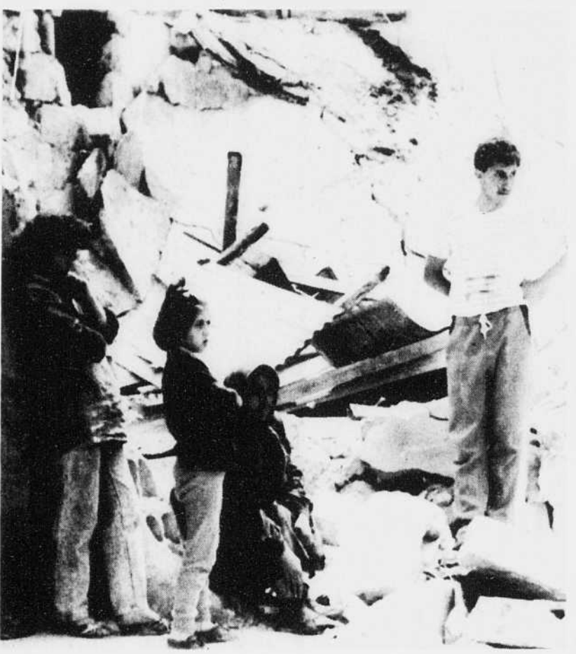
Une famille musulmane de Beyrouth a échappé de peu à la mort hier lorsque leur maison s'est effondrée avec la chute d'un obus. Les duels d'artillerie durent depuis le 14 mars.
