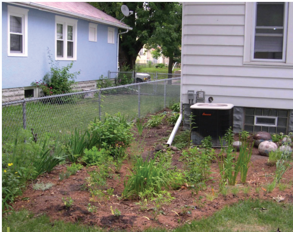
Un jardin de pluie capte le trop-plein d'un bac de rétention. Cette photo de Brian Ash est utilisée sous licence CC BY-SA 4.0.
