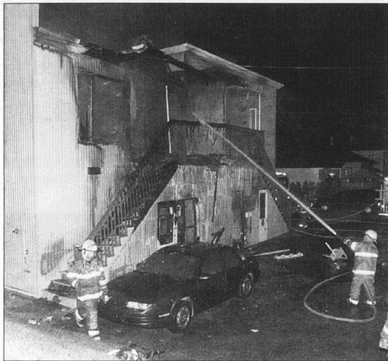
INACCESSIBLE - En ce qui a trait à l'incendie sur la rue du Vieux Pont, le sapeur Pierre Chouinard raconte qu'on a dû utiliser une échelle pour atteindre les appartements du second niveau. On voit ici l'escalier arrière du bâtiment, entièrement calciné.
