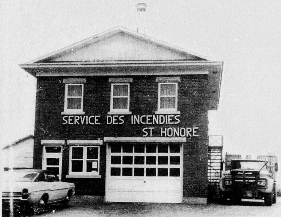
L'édifice municipal de St-Honoré a été construit en 1959. Alors que le premier étage sert de garage pour
