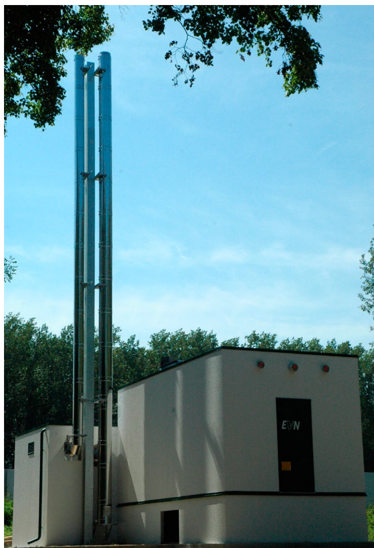
Chaudière à la biomasse.
