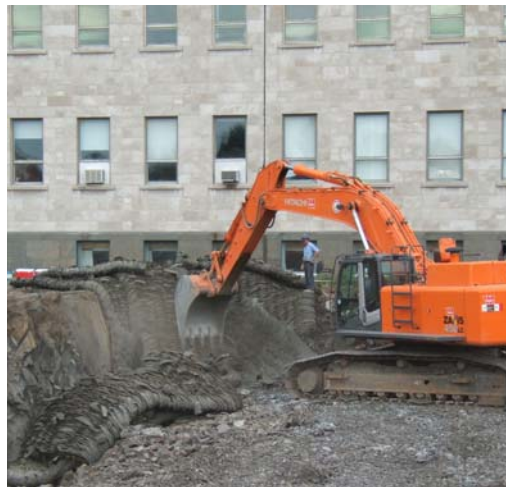
Figure 22 : Exposition du boutefeu lors de l'enlèvement des matelas pare-éclats
