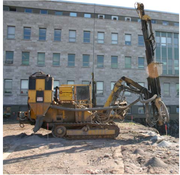
Figure 13 : Foreuse roto percussion avec système d'injection d'air utilisée lors des travaux en chantier
