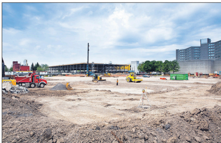
Entrepris au printemps, les travaux s'échelonnent jusqu'à l'été 2021.
