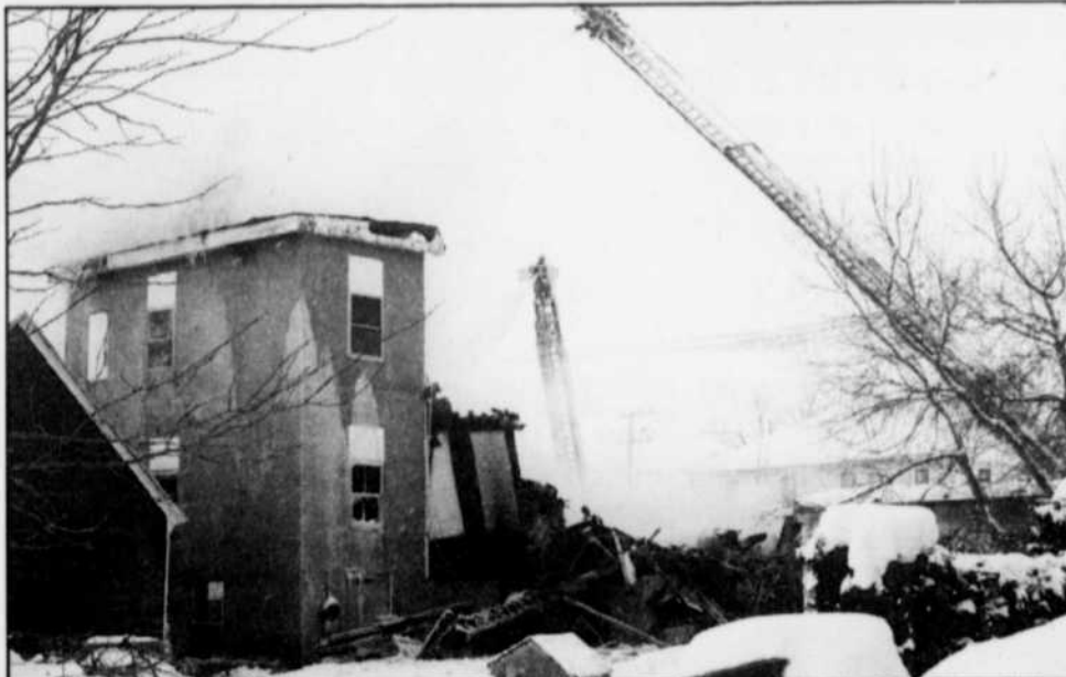
Des échelles aériennes ont été nécessaires vu la hauteur du bâtiment. (Photo Prac)
