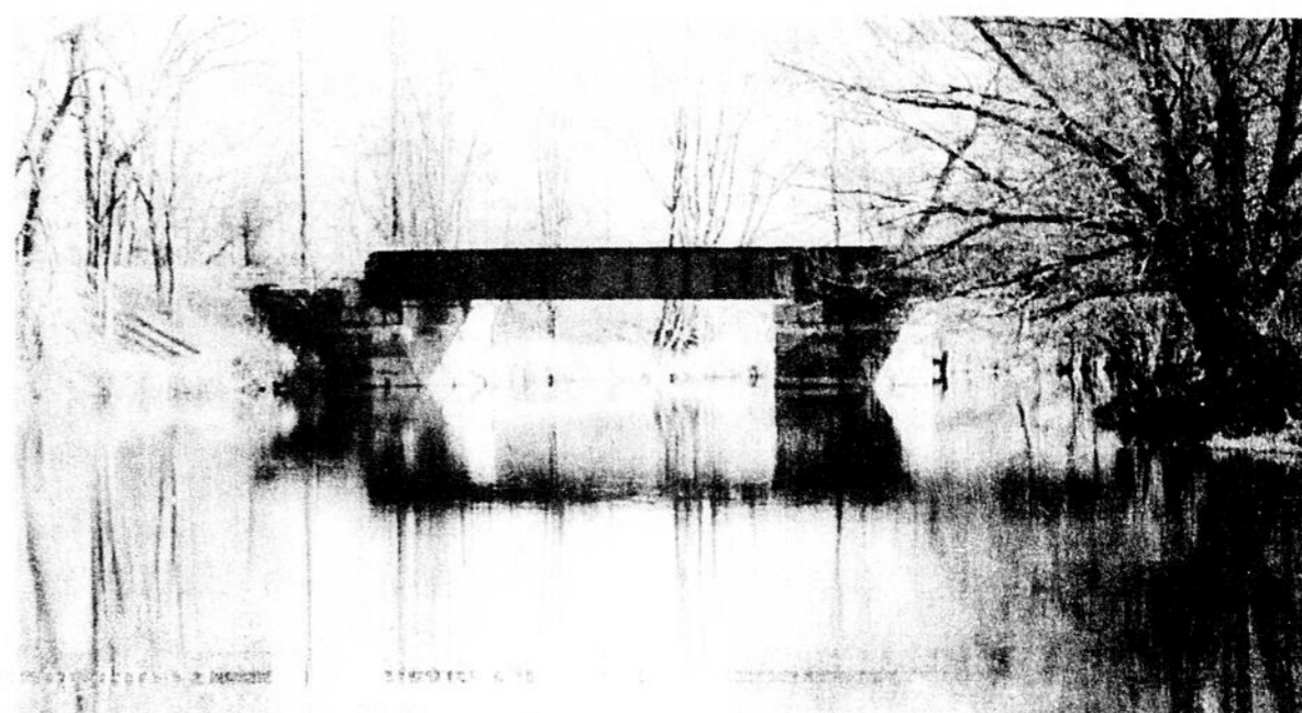
Le pont portant la voie ferrée Conrail, lequel relie les municipalités de Godmanchester et Elgin, sera réaménagé pour les véhicules. Tel est le projet du ministère des transports.
