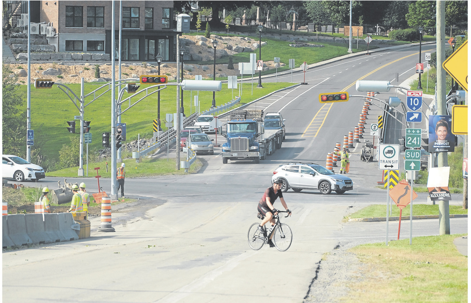
Les travaux ont repris à l'intersection de la route 241 et du boulevard de Bromont lundi. Le chantier doit s'échelonne sur 15 semaines. — LA VOIX DE L'EST, ALAIN DION
