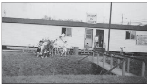
La deuxième roulotte de la maison des jeunes après son installation dans le parc Belvédère en 1987.
