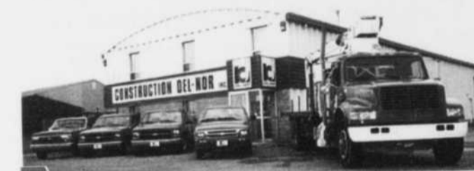
Construction Del-Nor à Chicoutimi, rue Manic.
