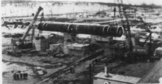
Installation d'un four rotatif (gazogène), 250 pieds de long et pesant 250 tonnes, Alcan Jonquière.
