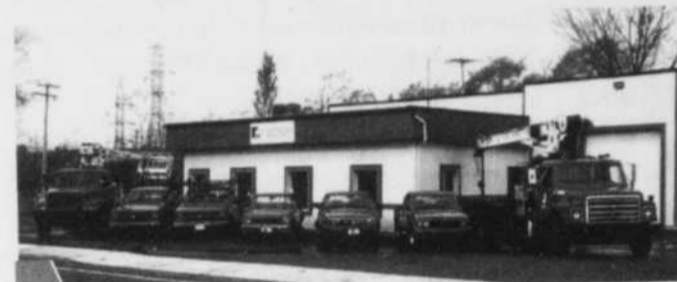
Construction Del-Nor à Tracy.
