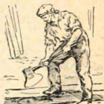
Le charpentier taille une poutre
