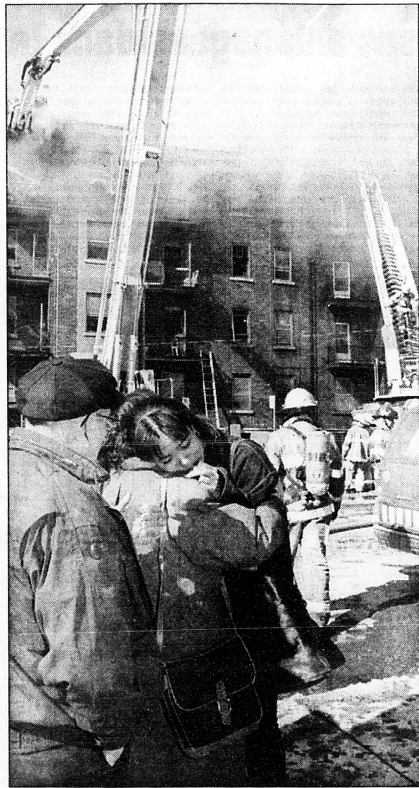
Plusieurs personnes ont été évacuées de l'immeuble en flammes ainsi que d'un édifice voisin, hier, sur le chemin Queen Mary.
