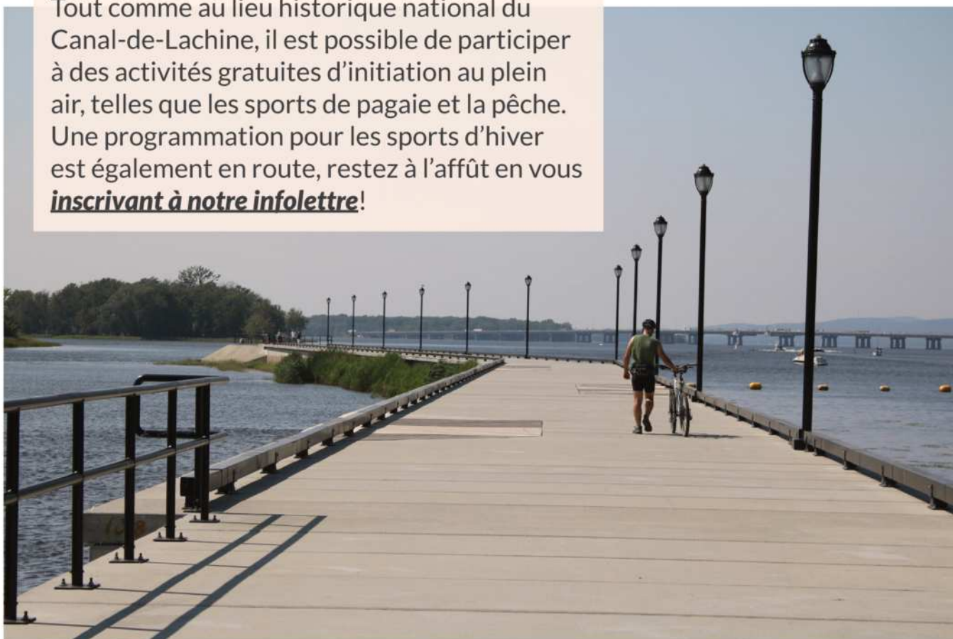
La jetée amont réaménagée du LHN du Canal-de-Sainte-Anne-de-Bellevue. Crédit photo : Parcs Canada.
