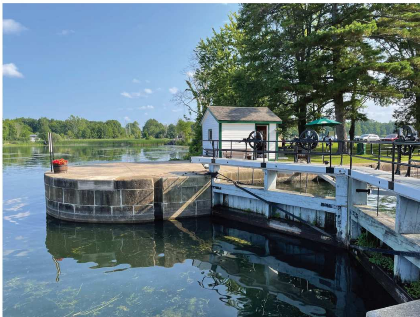
Écluse Narrow. Crédit photo : Pierre Bourgeois.
