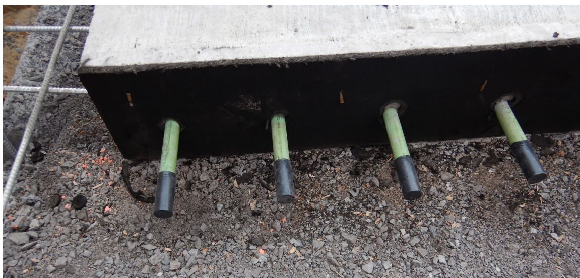
Photo A21.7 Installation des capuchons au chantier
