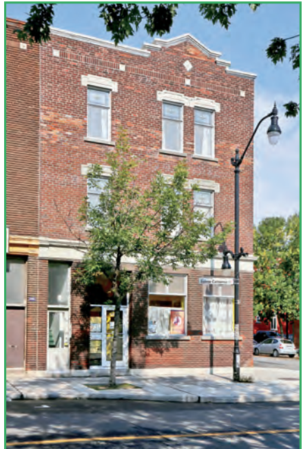
Crédit photo : Denis Tremblay, Bâtir son quartier
