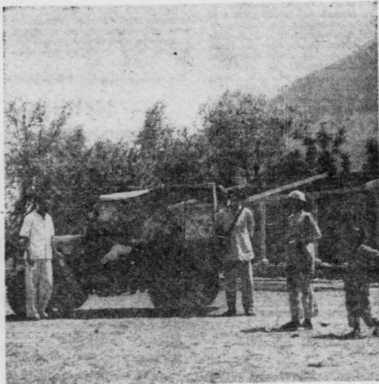
Mohinder Lal et sa jeep, don des Etats-Unis, près du bâtiment destiné à l'école et au foyer rural, que construisent les villageois de Mohal dans l'Himalaya.
