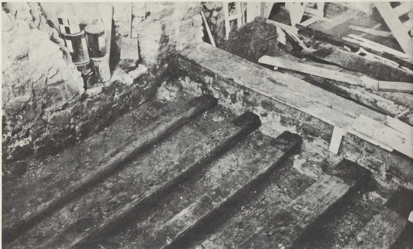
Photo III. Maçonnerie et poutres supportant le plancher de la cave de la Maison Villeray.
