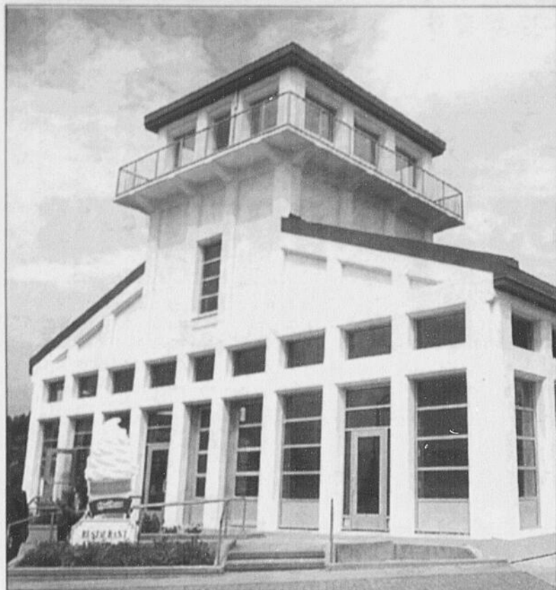
RÉNOVATION - Le «nouveau hangar» du Vieux port de Chicoutimi a pris des airs de jeunesse. (Photo Rocket Lavoie)
