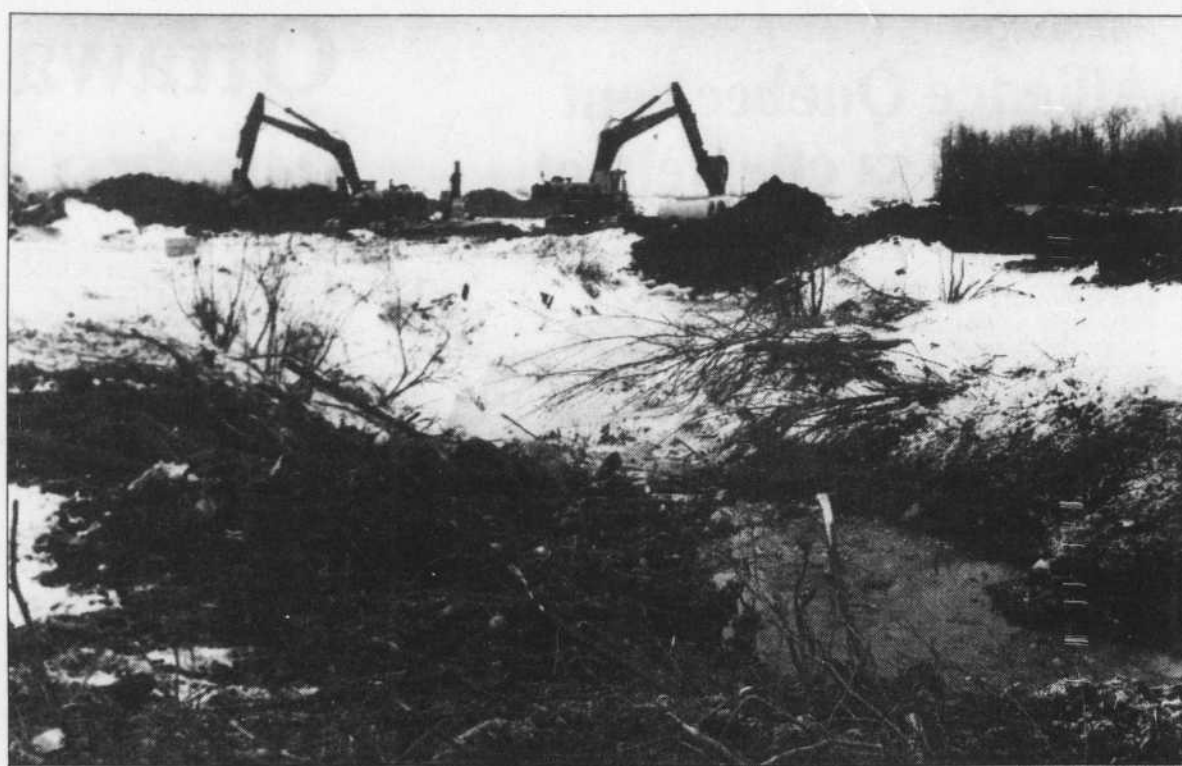
Laval est en train de transformer en un canal d'évacuation pour eaux usées le ruisseau La Pinière. Le nouveau canal déversera ces eaux non-traitées directement dans la rivière des Prairies.
