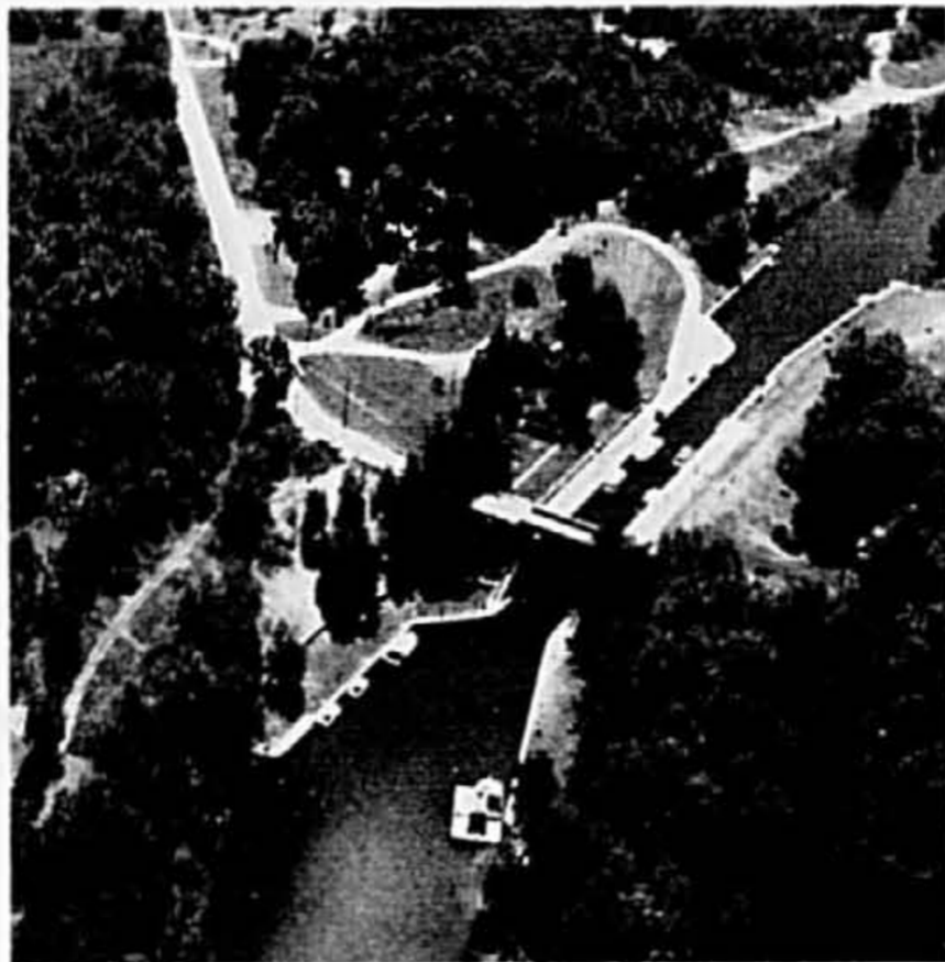
La voie navigable Trent-Severn.
