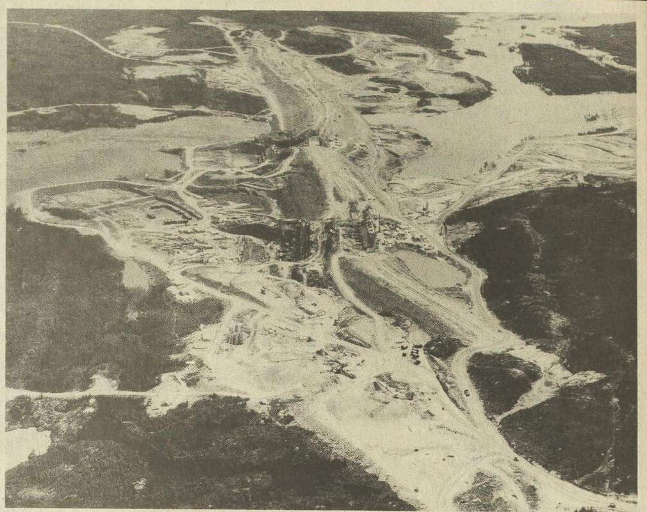
Les multiples voies d'accès au barrage de LG 3 circulent parmi les carrières et les dépôts adjacents d'où sont extraits les principaux matériaux de remblai de cet ouvrage gigantesque. Au premier plan (centre de la photo): les structures de la prise
