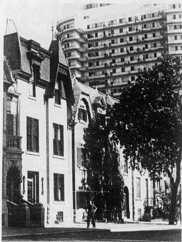
CONSTRUITS à la fin du siècle dernier, les logements du quartier sont généralement en bon état, solides et à loyer modique.
