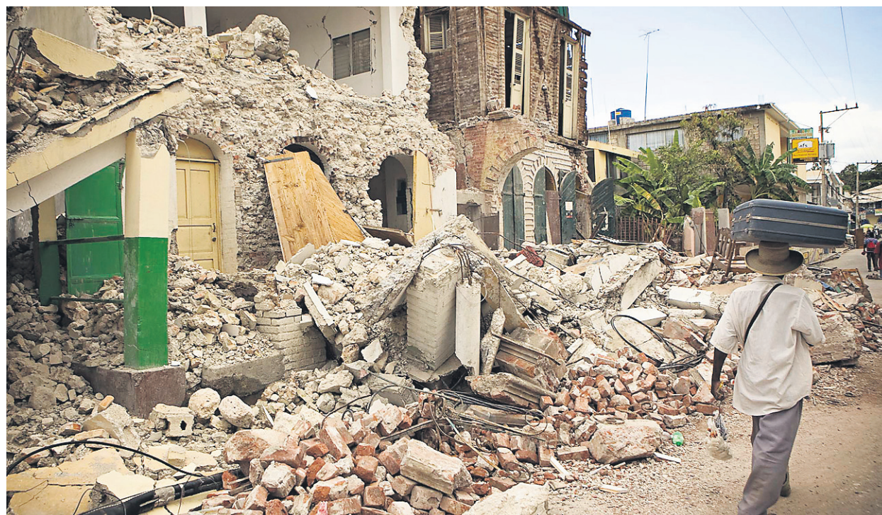
Plusieurs édifices de la ville de Jacmel se sont effondrés durant le séisme du 12 janvier 2009. Et après.
