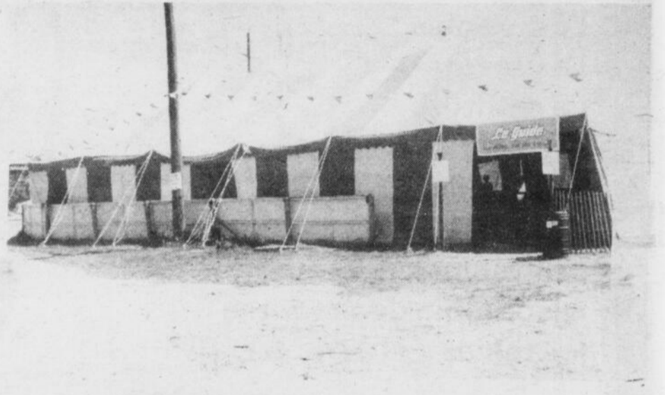
Le Guide aussi est sur les lieux. Une vue de la grande tente qu'on a installée sur le terrain de l'O.T.J. de Scott.
