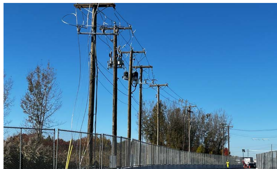
Hydro-Québec a mis en place les poteaux qui doivent acheminer l'électricité sur le site de Northvolt. (Photo : Frédéric Khalkhal)
