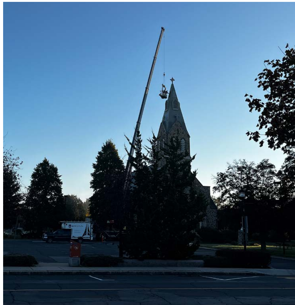
Les équipes de Telus font des travaux d'entretien sur l'antenne relais placée sur le toit de l'église. (Photo : Frédéric Khalkhal)
