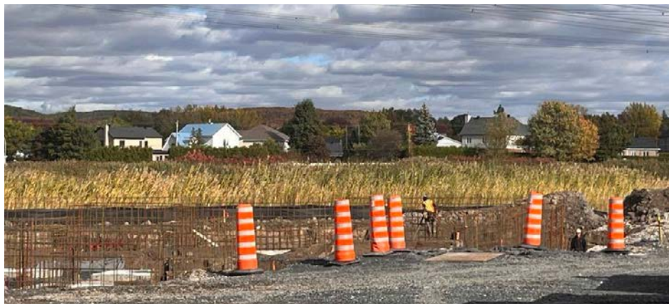
Les travaux du crématorium à Saint-Bruno se sont amorcés. (Photo : Frank Jr Rodi)
