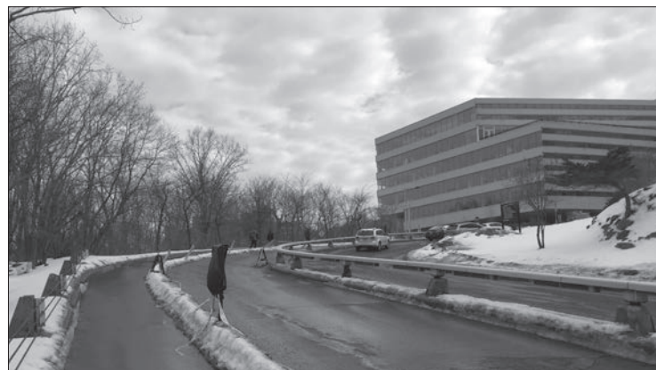
Depuis la fermeture de la rampe intérieure, un chemin balisé a été aménagé sur le Chemin de la Rampe. Photo © Maxime Callais
