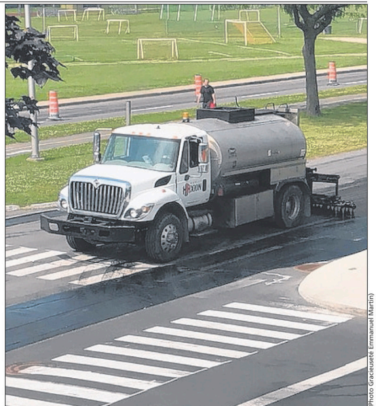
Les travaux de surfacage ont été réalisés une semaine après le marquage de la chaussée.
