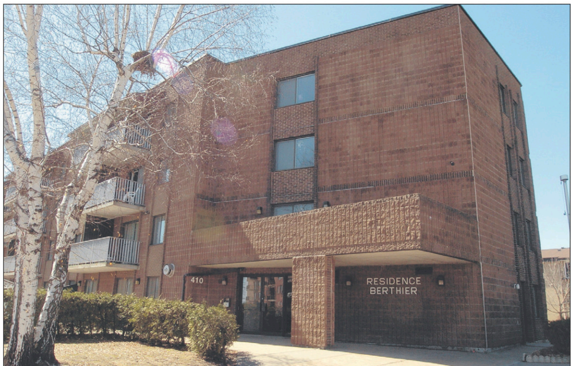
L'Office municipale d'habitation du Haut-Richelieu gère déjà 607 logements.
