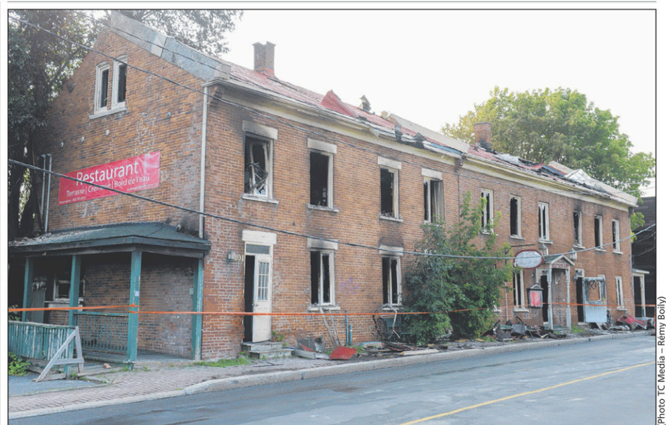
Georges Coulombe ne doute pas que l'immeuble incendié puisse être restauré.
