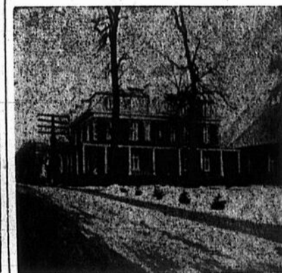
Presbytère de Berthier
