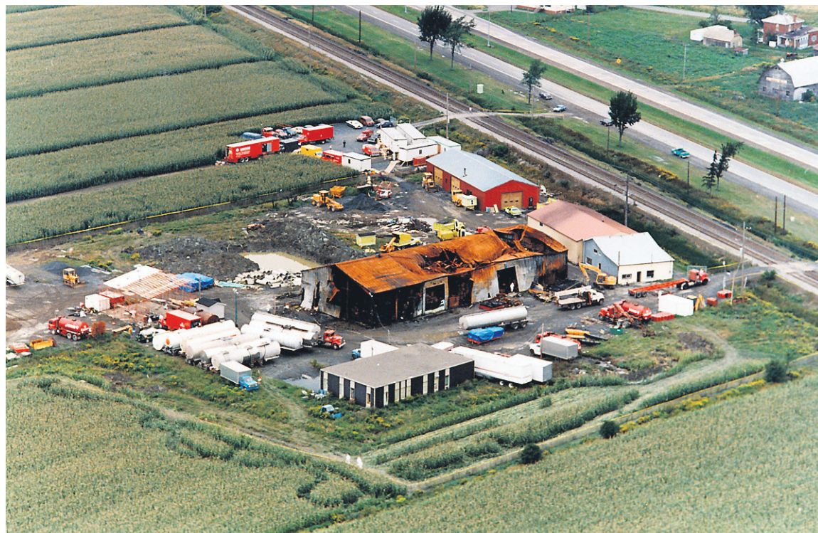
Plus de 35 000 gallons (130 000 litres) d'huile contaminée, venant surtout des transformateurs d'Hydro-Québec, s'étaient envolés en fumée, mais près de 300 barils intacts sont restés sur place.
