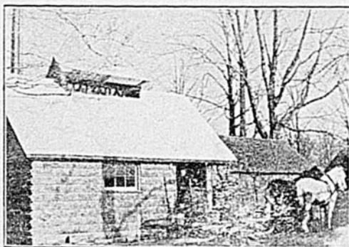
EXTERIEUR D'UNE SUCRERIE MODERNE
