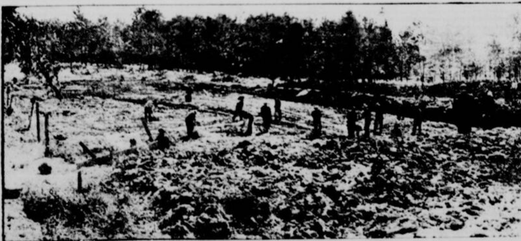
Les citoyens de la ville de St-Jérôme pourront dans un avenir assez rapproché aller prendre leur bain dans une immense piscine que le gouvernement provincial est à faire construire dans un parc, qui sera de toute beauté. On voit ici les ouvriers travaillant à cette piscine. A la droite de la photographie, l'on reconnaît M. Hermann Barrette, député de Terrebonne, causant avec notre représentant.
