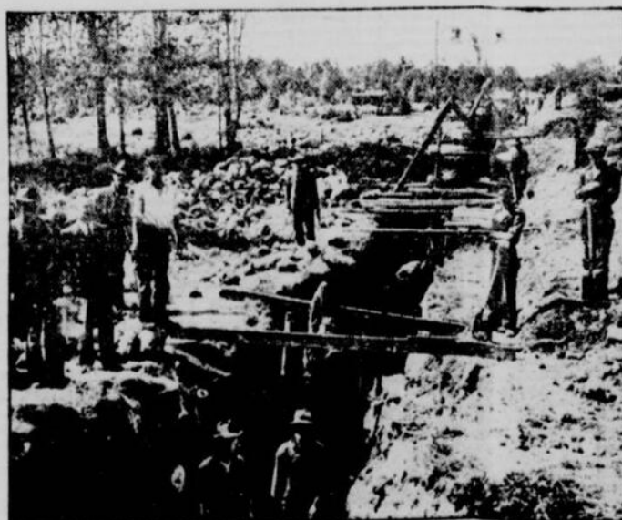
Les travaux actuellement en cours, à St-Jérôme, pour la construction des canaux d'égouts. Ils sont exécutés par le gouvernement provincial, comme travaux de chômage. A la gauche de la photographie, l'on remarque Me Hermann Barrette, député provincial, à côté du distributeur d'eau. — (Photo la "Patrie").
