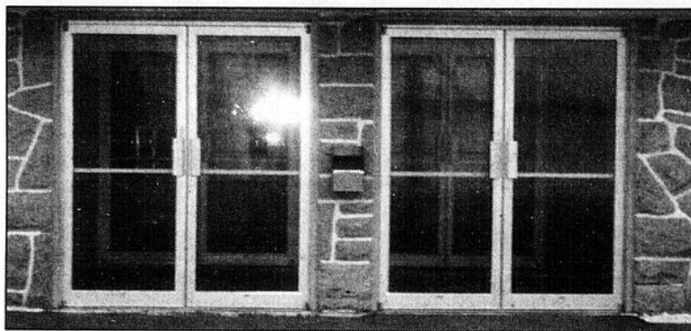
L'an dernier la Loto-aréna avait permis de restaurer les portes d'entrée.
