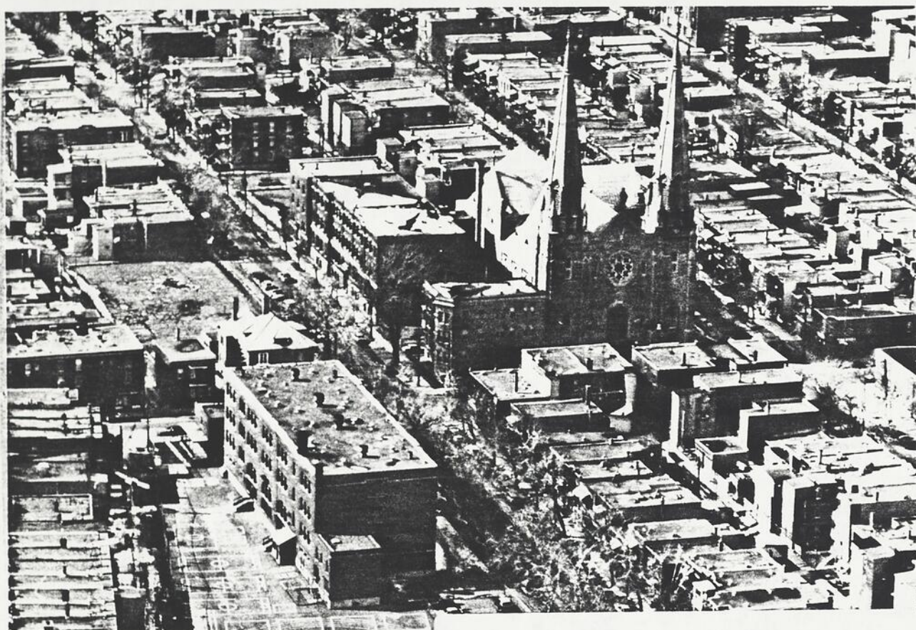
Fig. 168 Ensemble 5. Vue aérienne, J.R. Caron.
