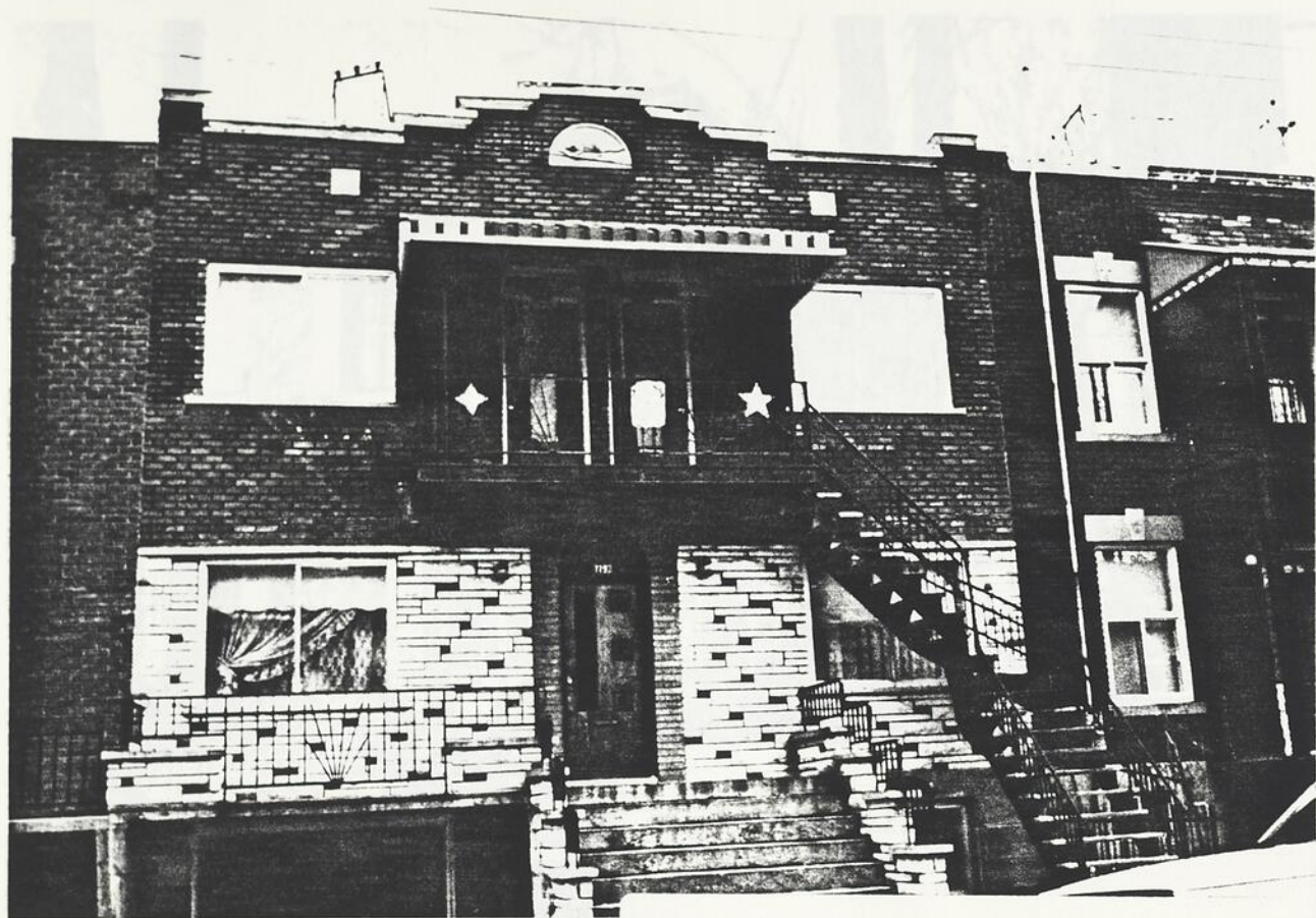
Fig. 99 Modification du revêtement et des ouvertures, 7789-93 Saint-Dominique.
